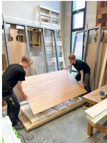
Hier dekken we de glaswolisolatie af met een Okumé multiplex plaat
