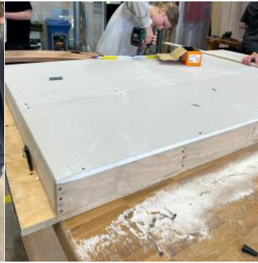
Volle bak plaatsen van de gipskartonplaten ☺
