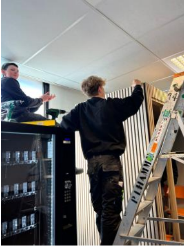
Plaatsen van de lattenwand.
