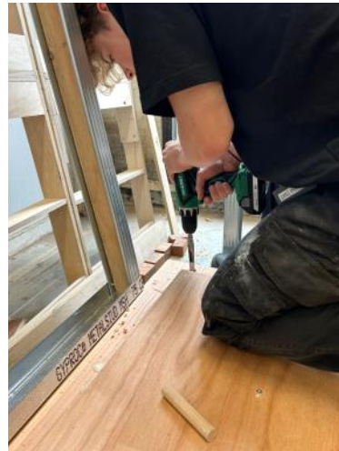
Ondertussen is de volgende groep gestart met het maken van topping(plafond). Dit gaan we niet met metalstuds maken maar met een houten constructie met overschotten van multiplex. Hier maken we verbindingen met de Domino.
