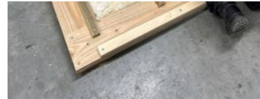
Isoleren van de bodem met glaswol.
